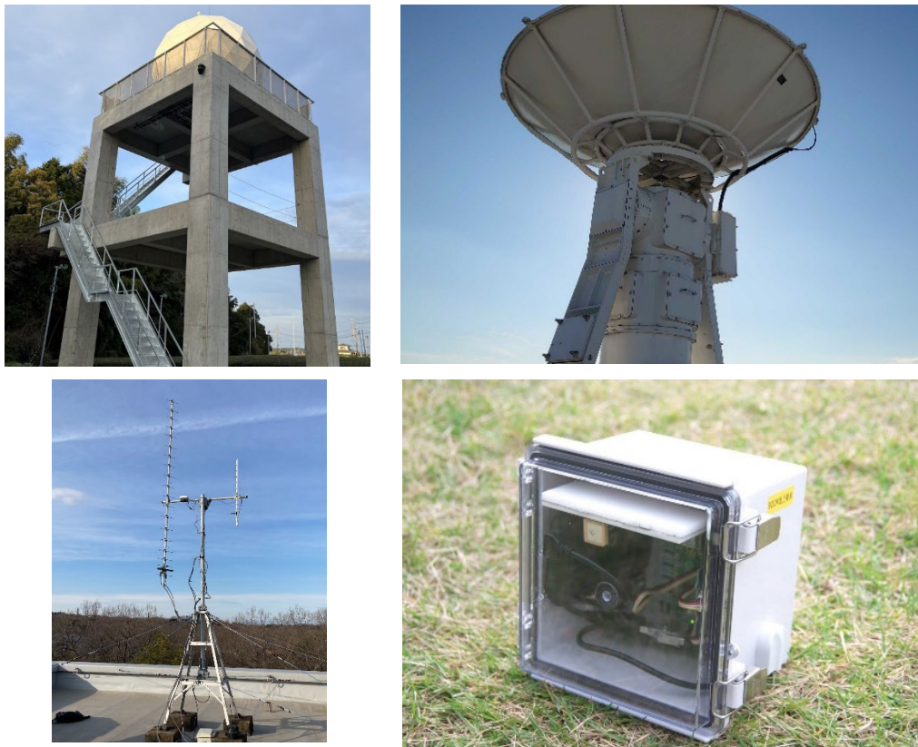
図5 (上左図) 榊アーケッジ・スペース所有 3.9m パラボラアンテナ (上右図) 埼玉県鳩山町 (東京電機大学) の 3m アンテナ (下左図) 920 MHz 帯小型省無線通信によるバックアップ通信固定局 (下右図) 920 MHz 帯小型省無線通信センサー取得可搬局
